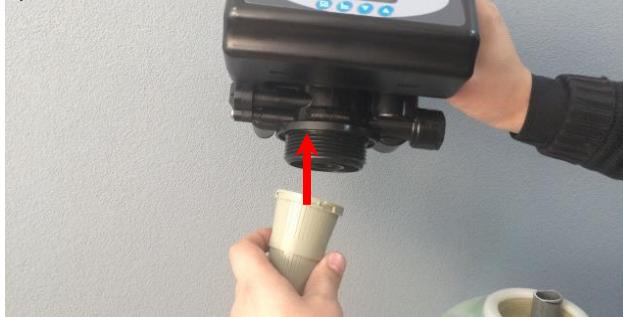
**2. Установи трубу в корпус фильтра, убедись что колпачок попал на посадочное место**
